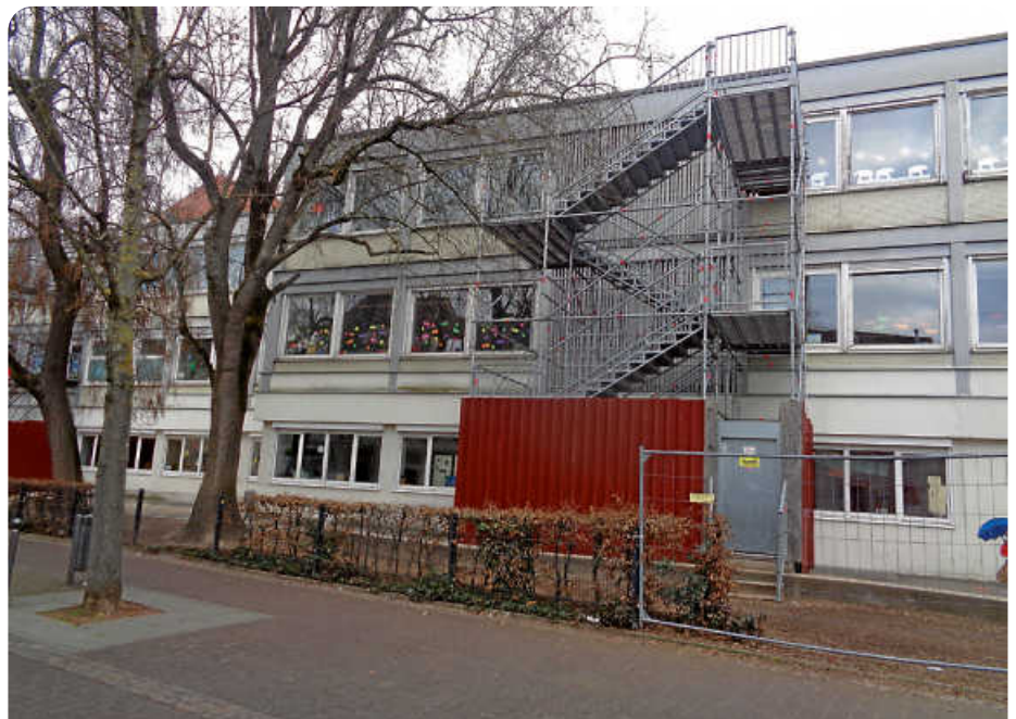
Die Container an der Durlacher Schloss-Schule sollen dieses Jahr wegkommen. Fotos: ras
