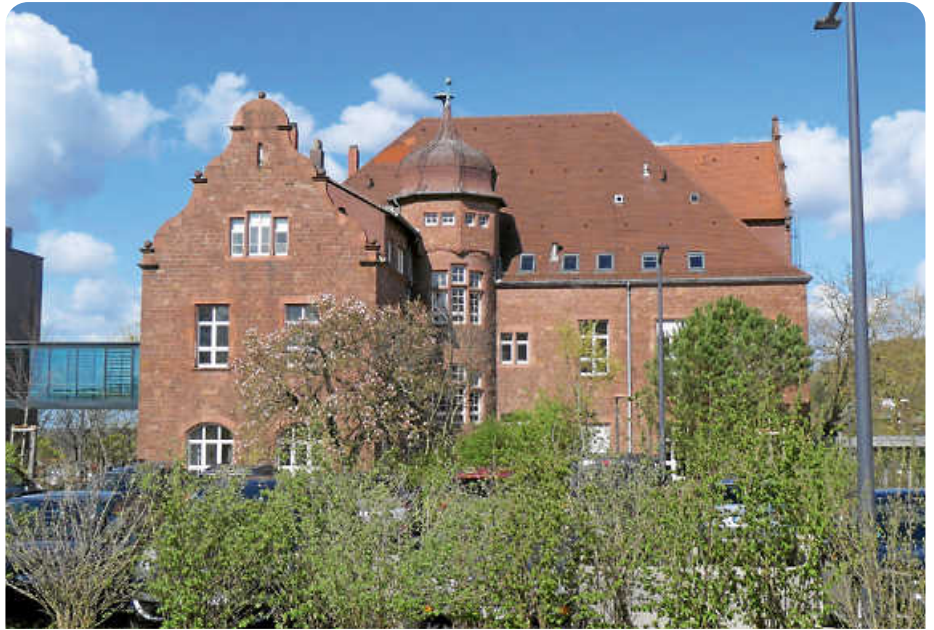
Das Hauptgebäude im LTZ Augustenburg ist aus Buntsandstein gebaut. Foto: rist.archiv
